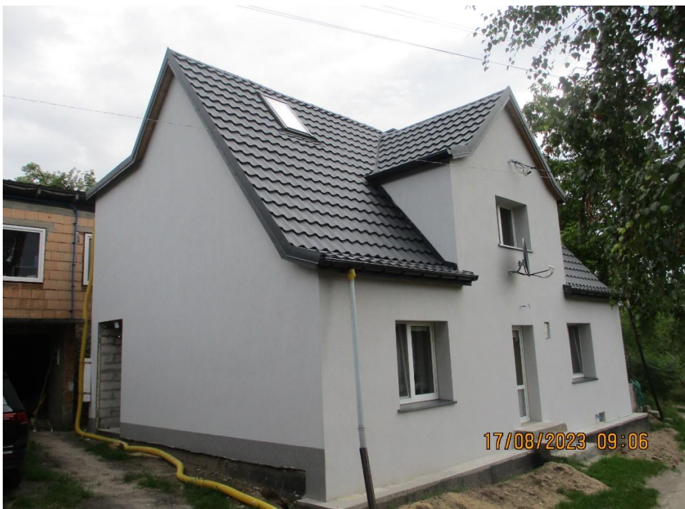
Fot. Budynek mieszkalny po termomodernizacji
