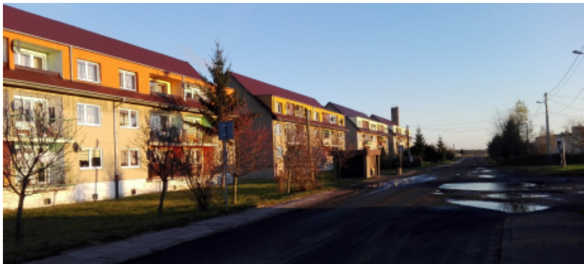
Rysunek 36. Zły stan drogi i chodnika w centrum wsi
