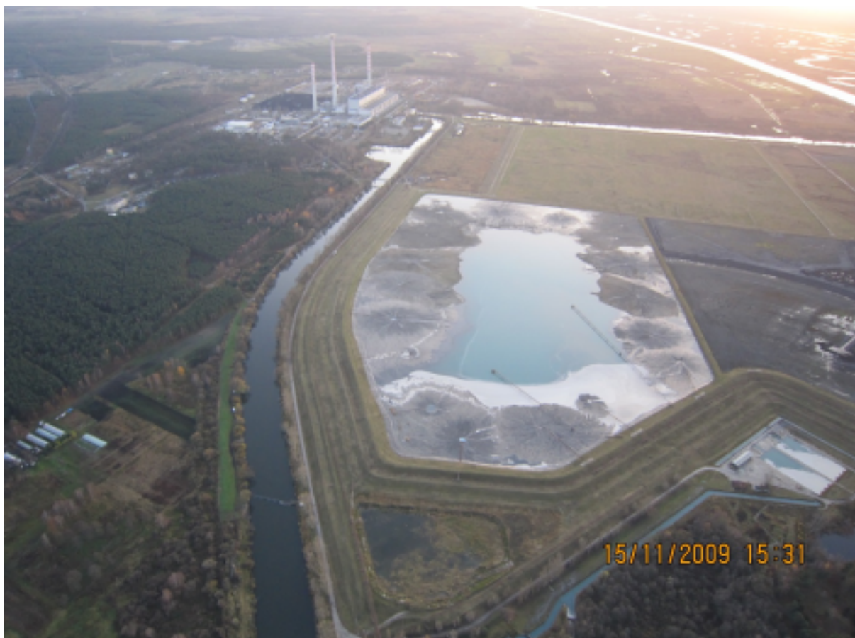
Zdjęcie 47. Kanał Ciepły przy Elektrowni Dolna Odra
